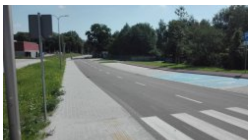
Budowa ulicy Scheiblera w Czeladzi
