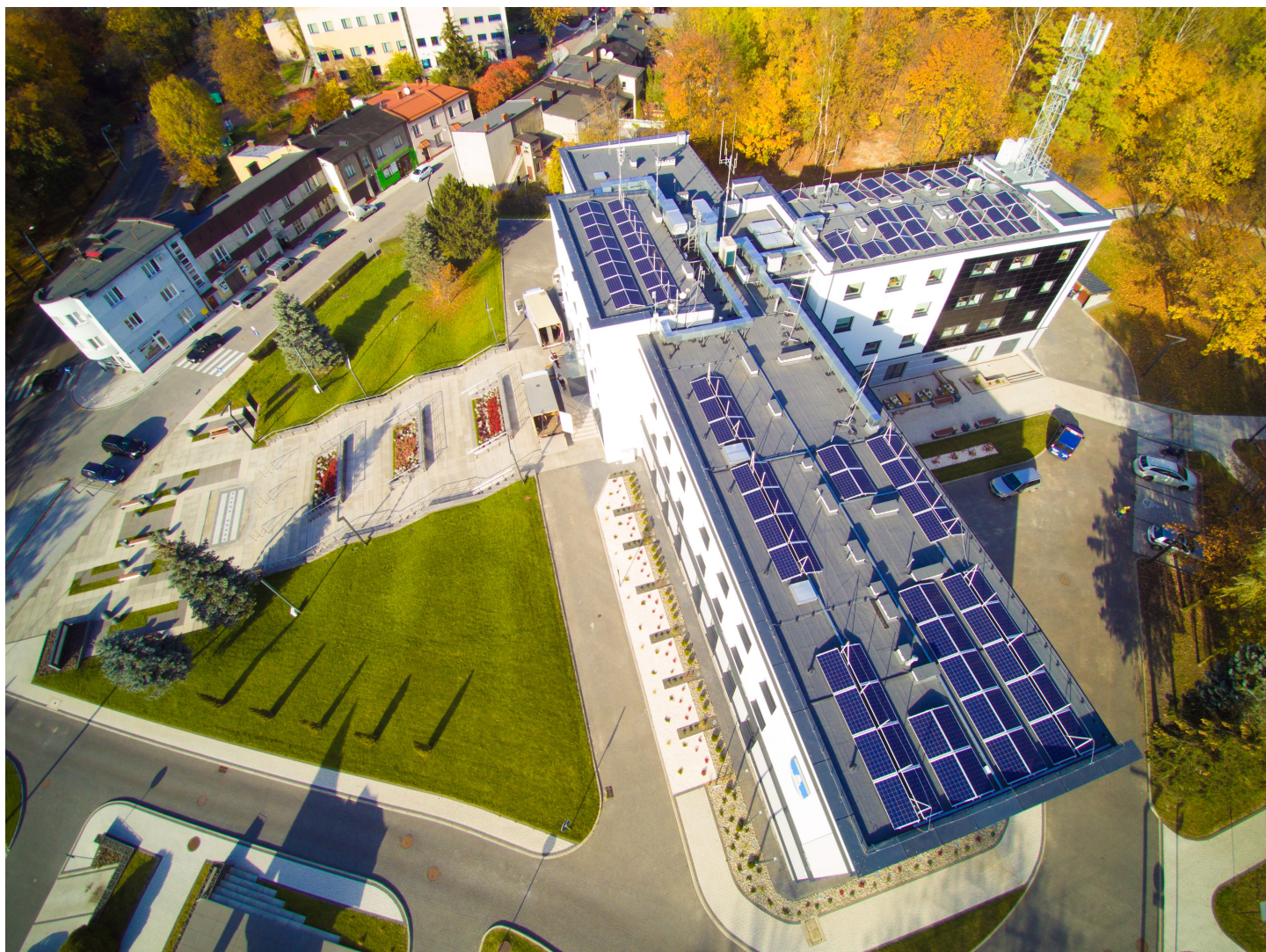
Widok na budynek Urzędu Miasta z lotu ptaka
