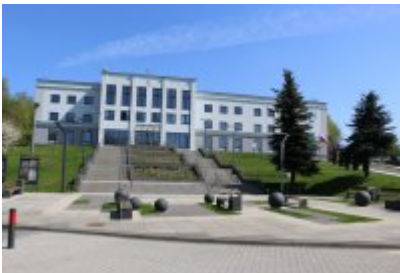
• Termomodernizacja budynku Urzędu Miasta Czeladź
