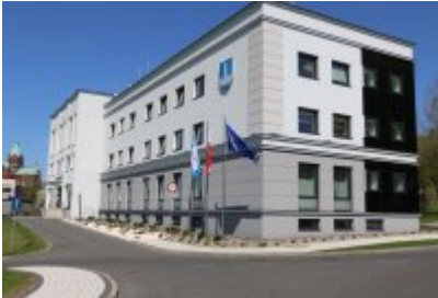
• Termomodernizacja budynku Urzędu Miasta Czeladź
