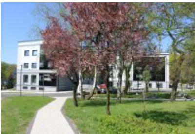
• Termomodernizacja budynku Urzędu Miasta Czeladź
