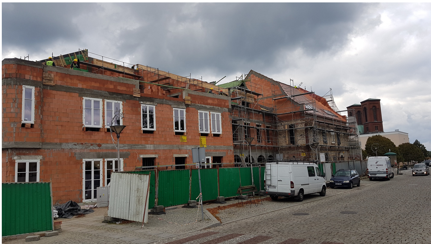
Rynek 22 - w trakcie realizacji
