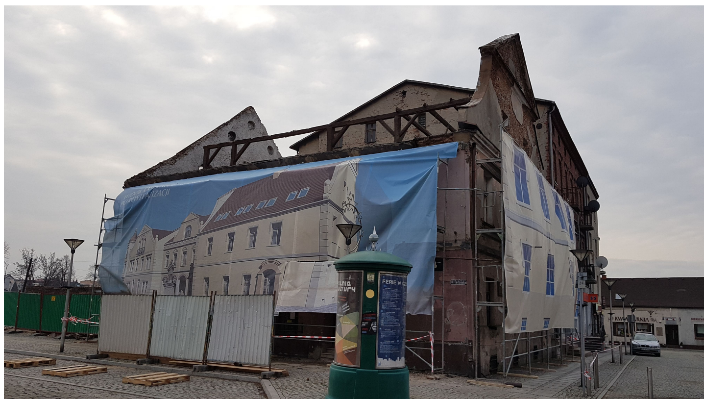
CUSiAL Rynek 22, w trakcie prac
