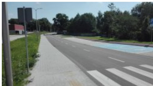
Budowa ulicy Scheiblera w Czeladzi
