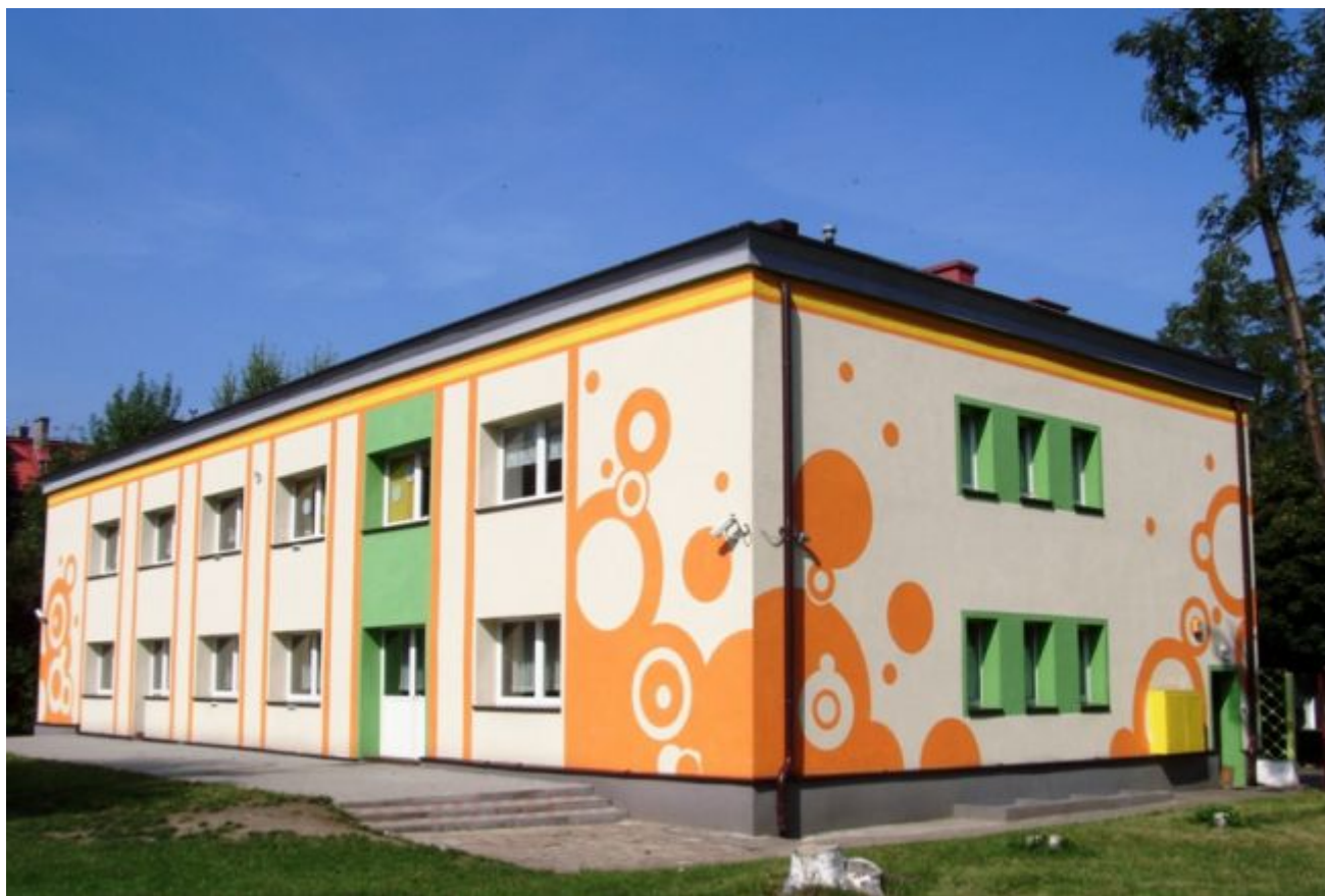
Budynek Przedszkola nr 7 przy ul. Waryńskiego po modernizacji
