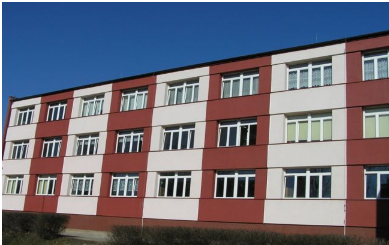
Budynek Gimnazjum nr 3 przy ul. Lwowskiej po modernizacji
