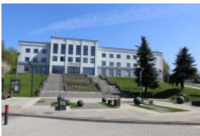
Termomodernizacja budynku Urzędu Miasta Czeladź
