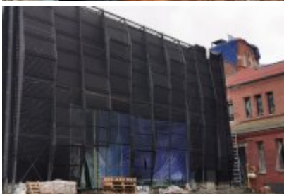
• Remont dawnej cechowni KWK Saturn w Czeladzi
