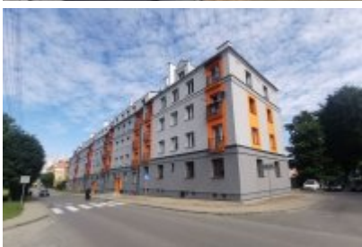
• Termomodernizacja budynku komunalnego przy ul. Tuwima
