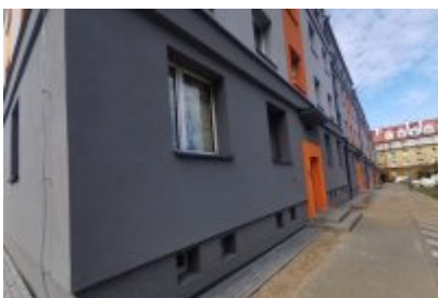
• Termomodernizacja budynku komunalnego przy ul. Tuwima
