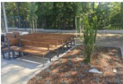
• Drzewa wokół remontowanej cechowni
