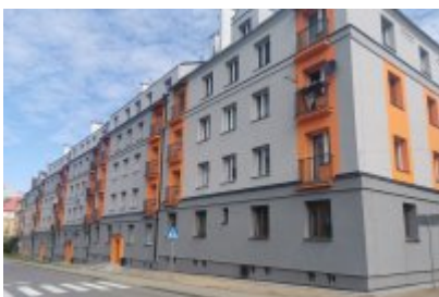
• Termomodernizacja budynku komunalnego przy ul. Tuwima
