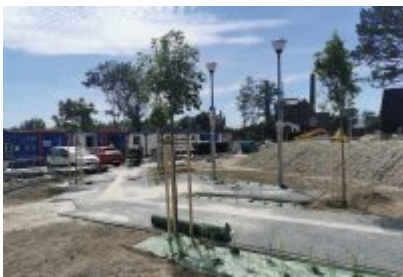
• Drzewa wokół remontowanej cechowni
