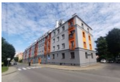
Termomodernizacja budynku komunalnego przy ul. Tuwima
