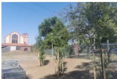
Drzewa wokół remontowanej cechowni
