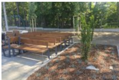
Drzewa wokół remontowanej cechowni
