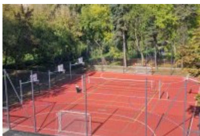
Modernizacja terenu przyszkolnego w SP4
