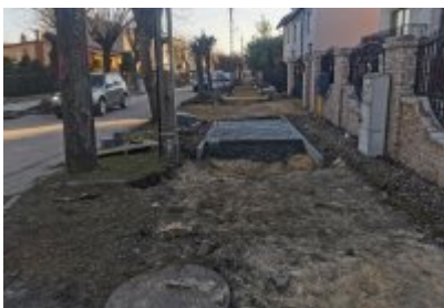
• Remont ulicy Polnej w Czeladzi
