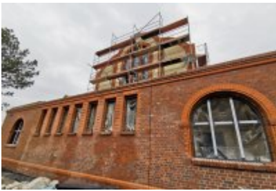
• Remont dawnej cechowni KWK Saturn w Czeladzi
