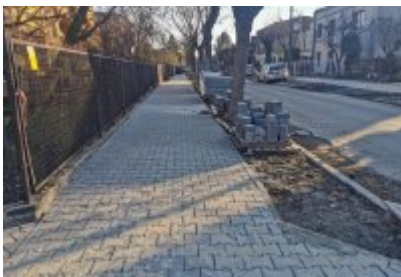
• Remont ulicy Polnej w Czeladzi
