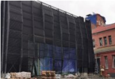
• Remont dawnej cechowni KWK Saturn w Czeladzi
