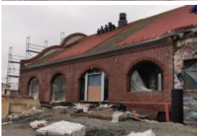
• Remont dawnej cechowni KWK Saturn w Czeladzi
