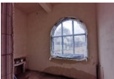
• Remont dawnej cechowni KWK Saturn w Czeladzi
