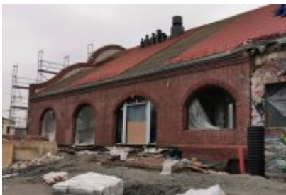
• Remont dawnej cechowni KWK Saturn w Czeladzi
