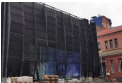
• Remont dawnej cechowni KWK Saturn w Czeladzi
