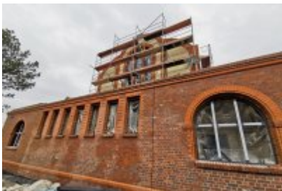
• Remont dawnej cechowni KWK Saturn w Czeladzi
