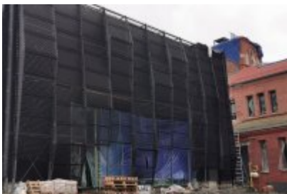
• Remont dawnej cechowni KWK Saturn w Czeladzi
