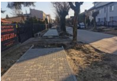
• Remont ulicy Polnej w Czeladzi
