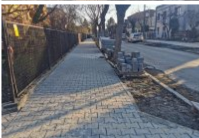
• Remont ulicy Polnej w Czeladzi
