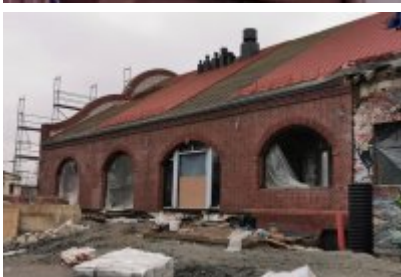
• Remont dawnej cechowni KWK Saturn w Czeladzi
