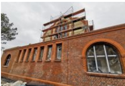
• Remont dawnej cechowni KWK Saturn w Czeladzi
