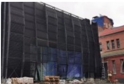
• Remont dawnej cechowni KWK Saturn w Czeladzi
