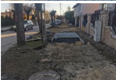
• Remont ulicy Polnej w Czeladzi
