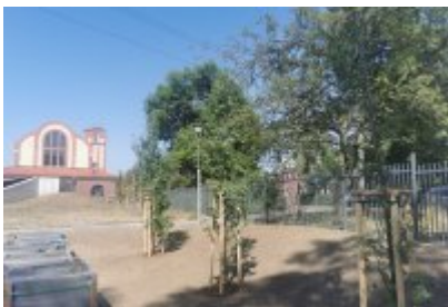
• Drzewa wokół remontowanej cechowni
