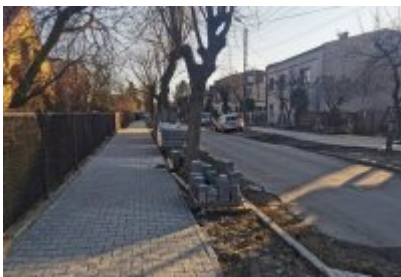
• Remont ulicy Polnej w Czeladzi
