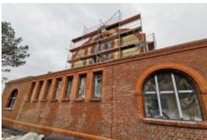
• Remont dawnej cechowni KWK Saturn w Czeladzi
