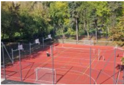
Modernizacja terenu przyszkolnego w SP4
