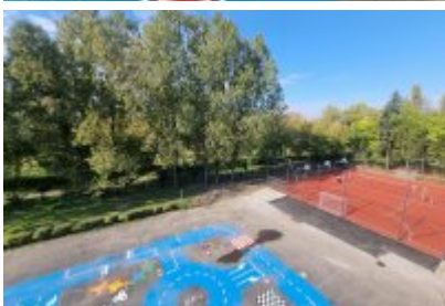
Modernizacja terenu przyszkolnego w SP4
