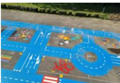
Modernizacja terenu przyszkolnego w SP4
