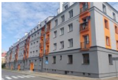
• Termomodernizacja budynku komunalnego przy ul. Tuwima
