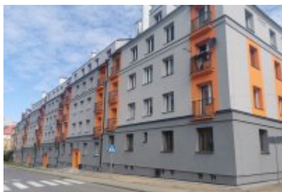
• Termomodernizacja budynku komunalnego przy ul. Tuwima
