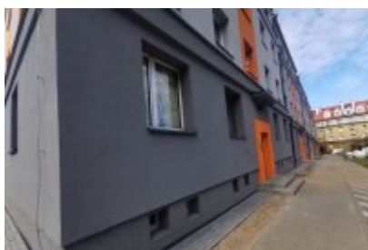
• Termomodernizacja budynku komunalnego przy ul. Tuwima
