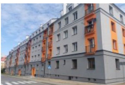
Termomodernizacja budynku komunalnego przy ul. Tuwima
