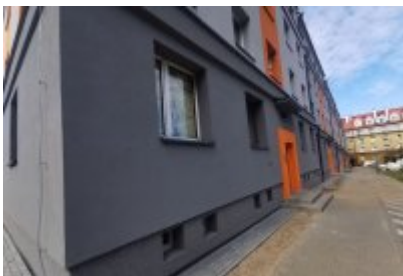
• Termomodernizacja budynku komunalnego przy ul. Tuwima
