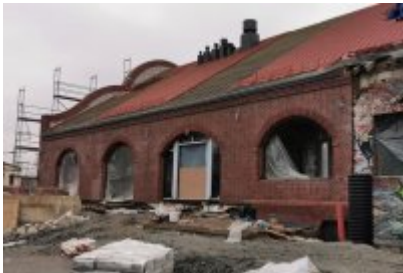
Remont dawnej cechowni KWK Saturn w Czeladzi
