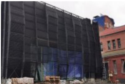
Remont dawnej cechowni KWK Saturn w Czeladzi
