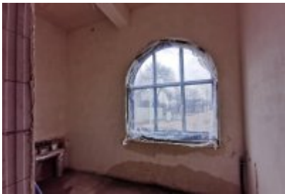
Remont dawnej cechowni KWK Saturn w Czeladzi
