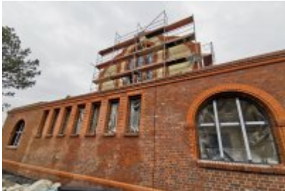
Remont dawnej cechowni KWK Saturn w Czeladzi
