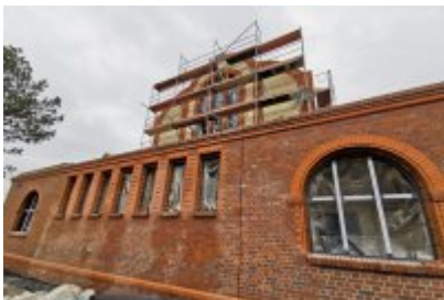
Remont dawnej cechowni KWK Saturn w Czeladzi
