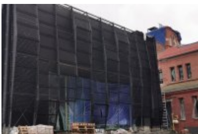
Remont dawnej cechowni KWK Saturn w Czeladzi
