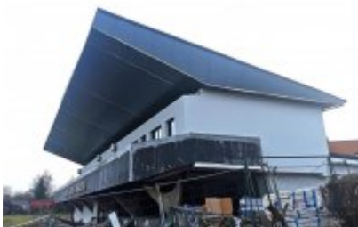
• Remont trybuny stadionu
