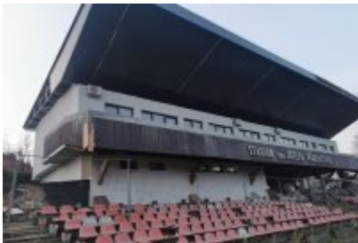
• Remont trybuny stadionu
