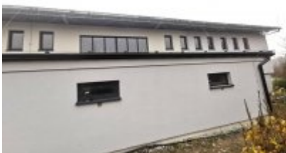
• Remont trybuny stadionu
