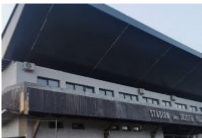
• Remont trybuny stadionu
