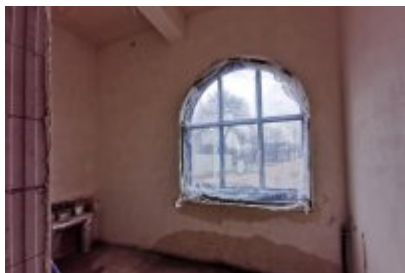
Remont dawnej cechowni KWK Saturn w Czeladzi
