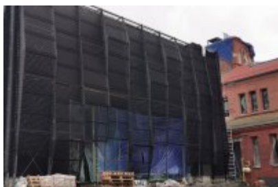
Remont dawnej cechowni KWK Saturn w Czeladzi
