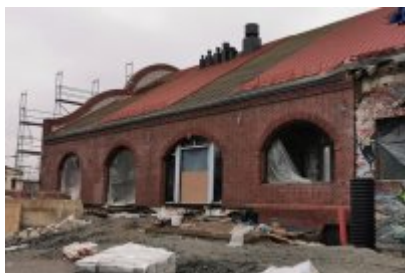
Remont dawnej cechowni KWK Saturn w Czeladzi
