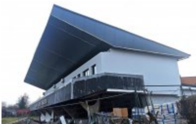
• Remont trybuny stadionu
