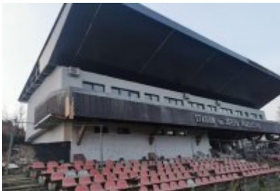
• Remont trybuny stadionu
