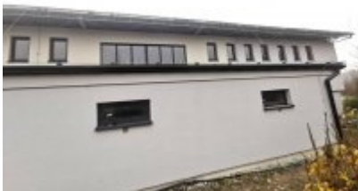
• Remont trybuny stadionu
