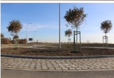
Obwodnica osiedla Piłsudskiego w Czeladzi
