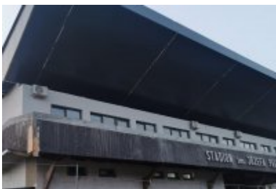
• Remont trybuny stadionu
