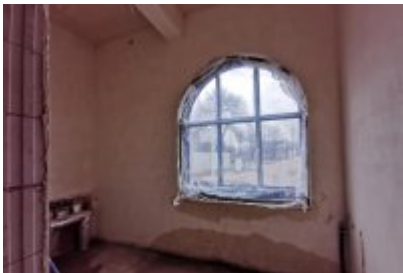
Remont dawnej cechowni KWK Saturn w Czeladzi
