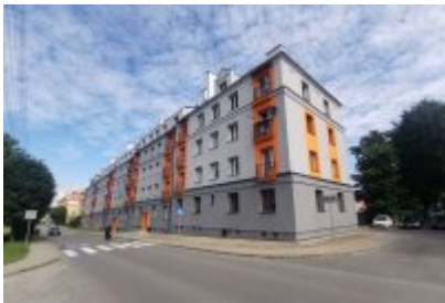
• Termomodernizacja budynku komunalnego przy ul. Tuwima
