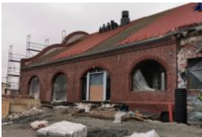
Remont dawnej cechowni KWK Saturn w Czeladzi
