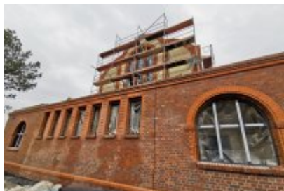
Remont dawnej cechowni KWK Saturn w Czeladzi
