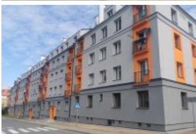
Termomodernizacja budynku komunalnego przy ul. Tuwima
