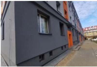
• Termomodernizacja budynku komunalnego przy ul. Tuwima
