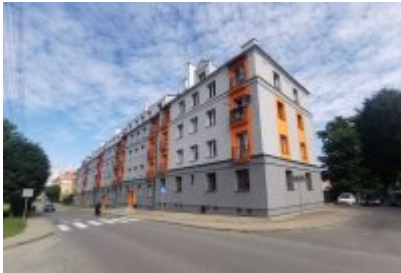
• Termomodernizacja budynku komunalnego przy ul. Tuwima
