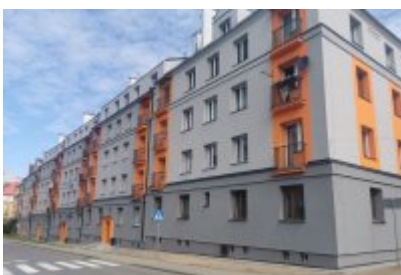
Termomodernizacja budynku komunalnego przy ul. Tuwima
