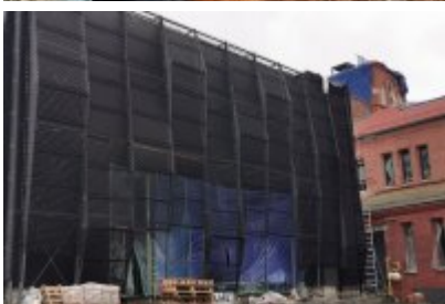
Remont dawnej cechowni KWK Saturn w Czeladzi
