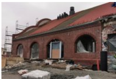
Remont dawnej cechowni KWK Saturn w Czeladzi
