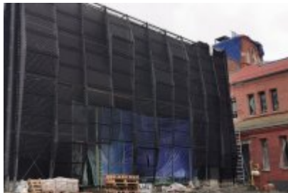
Remont dawnej cechowni KWK Saturn w Czeladzi
