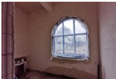
Remont dawnej cechowni KWK Saturn w Czeladzi
