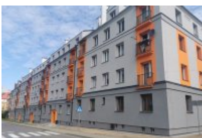
Termomodernizacja budynku komunalnego przy ul. Tuwima
