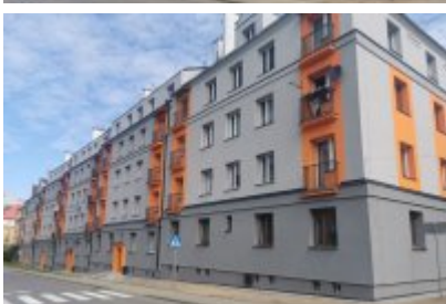
Termomodernizacja budynku komunalnego przy ul. Tuwima
