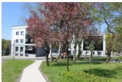
• Termomodernizacja budynku Urzędu Miasta Czeladź
