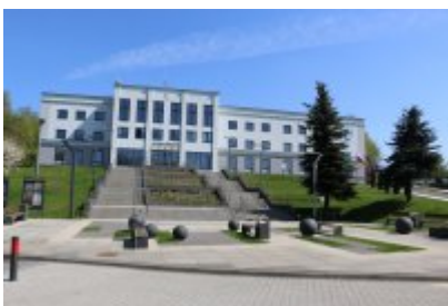
Termomodernizacja budynku Urzędu Miasta Czeladź
