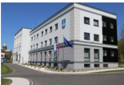
Termomodernizacja budynku Urzędu Miasta Czeladź
