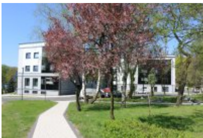
Termomodernizacja budynku Urzędu Miasta Czeladź
