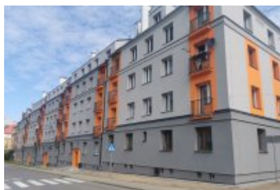
• Termomodernizacja budynku komunalnego przy ul. Tuwima
