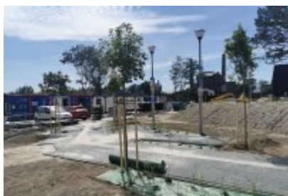
Drzewa wokół remontowanej cechowni
