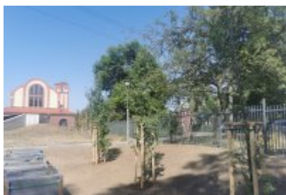
Drzewa wokół remontowanej cechowni
