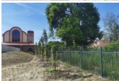
Drzewa wokół remontowanej cechowni
