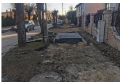
Remont ulicy Polnej w Czeladzi
