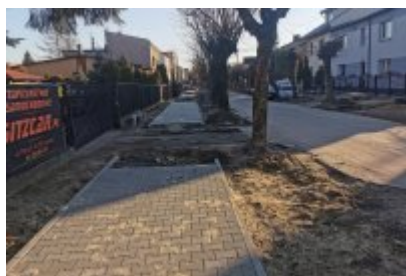
• Remont ulicy Polnej w Czeladzi
