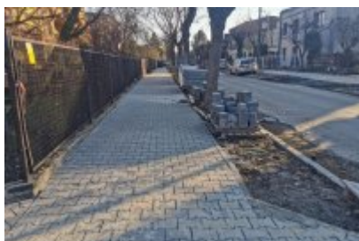
Remont ulicy Polnej w Czeladzi
