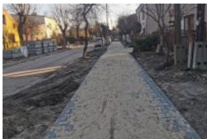
Remont ulicy Polnej w Czeladzi
