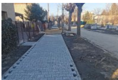
Remont ulicy Polnej w Czeladzi
