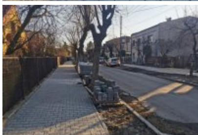
Remont ulicy Polnej w Czeladzi
