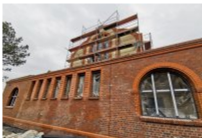
Remont dawnej cechowni KWK Saturn w Czeladzi
