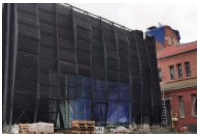
Remont dawnej cechowni KWK Saturn w Czeladzi
