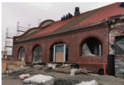
Remont dawnej cechowni KWK Saturn w Czeladzi
