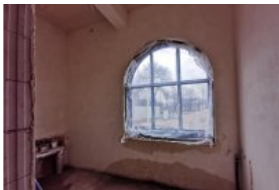
Remont dawnej cechowni KWK Saturn w Czeladzi
