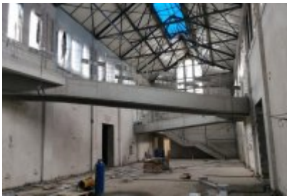
• Remont dawnej cechowni KWK Saturn w Czeladzi
