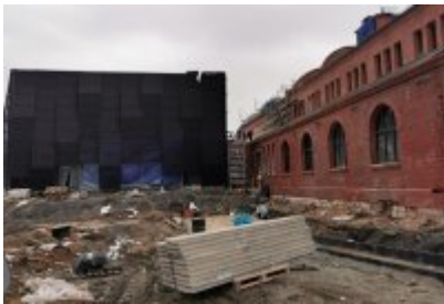
Remont dawnej cechowni KWK Saturn w Czeladzi
