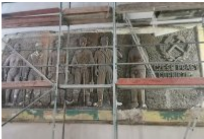
• Remont dawnej cechowni KWK Saturn w Czeladzi
