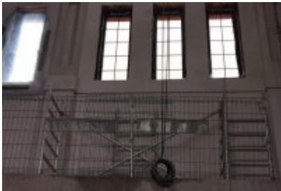
• Remont dawnej cechowni KWK Saturn w Czeladzi
