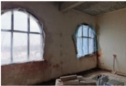
• Remont dawnej cechowni KWK Saturn w Czeladzi
