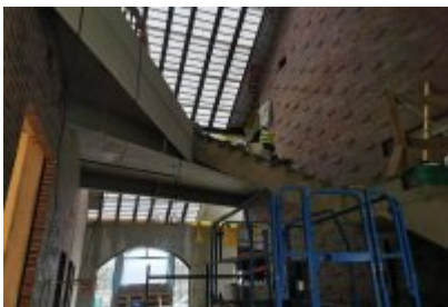
• Remont dawnej cechowni KWK Saturn w Czeladzi
