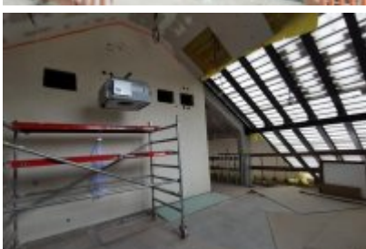
• Remont dawnej cechowni KWK Saturn w Czeladzi
