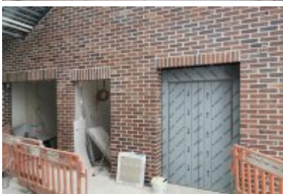
• Remont dawnej cechowni KWK Saturn w Czeladzi
