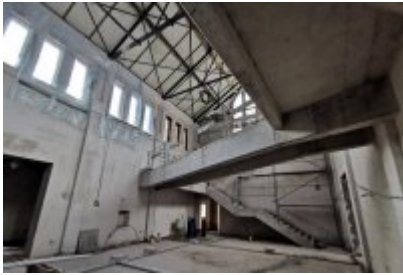
• Remont dawnej cechowni KWK Saturn w Czeladzi
