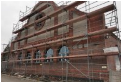
• Remont dawnej cechowni KWK Saturn w Czeladzi
