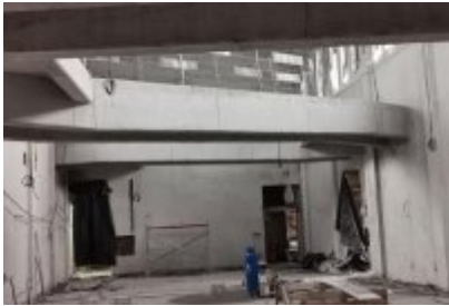
• Remont dawnej cechowni KWK Saturn w Czeladzi
