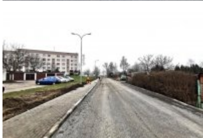
• Ulica Siemianowicka gotowa
