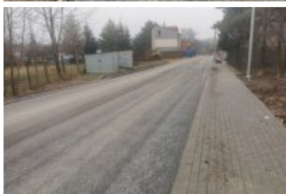
• Ulica Siemianowicka gotowa
