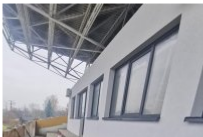
Remont trybuny stadionu
