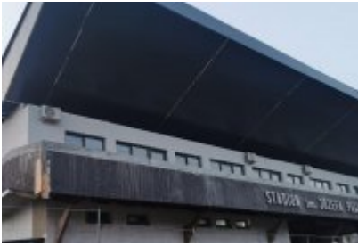
• Remont trybuny stadionu
