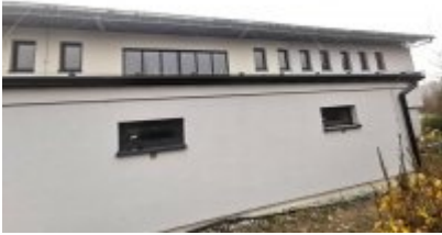
• Remont trybuny stadionu
