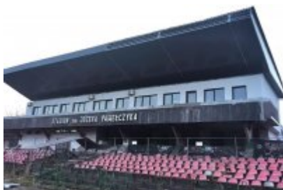
Remont trybuny stadionu
