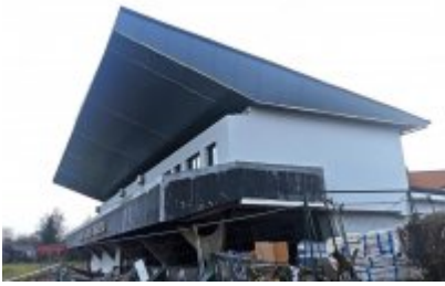
• Remont trybuny stadionu
