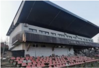
• Remont trybuny stadionu
