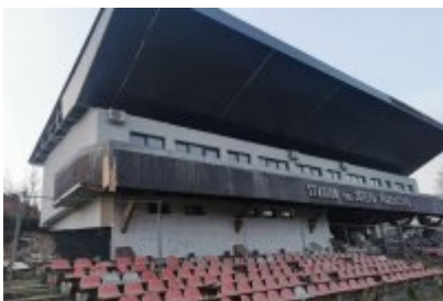
• Remont trybuny stadionu
