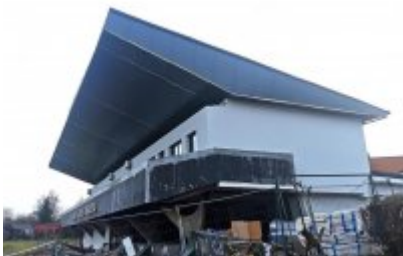
• Remont trybuny stadionu
