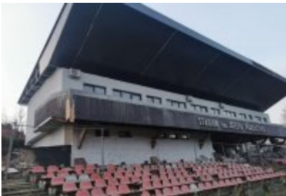
• Remont trybuny stadionu
