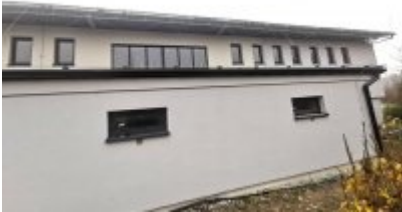
• Remont trybuny stadionu
