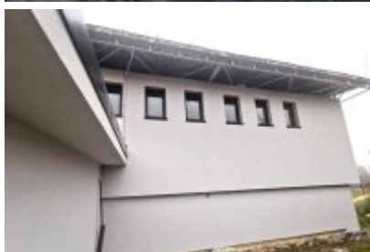
• Remont trybuny stadionu
