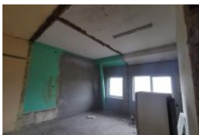
• Remont trybuny stadionu
