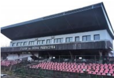
• Remont trybuny stadionu
