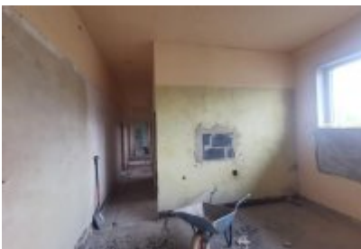
• Remont trybuny stadionu
