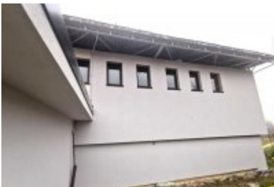
• Remont trybuny stadionu
