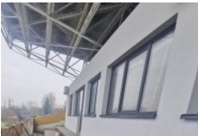
• Remont trybuny stadionu
