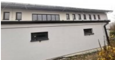
• Remont trybuny stadionu
