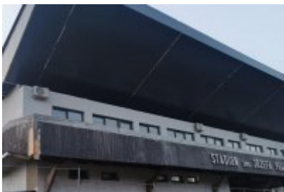
• Remont trybuny stadionu
