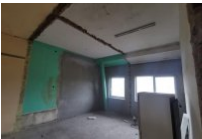
• Remont trybuny stadionu
