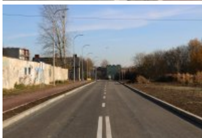
• Obwodnica osiedla Piłsudskiego w Czeladzi
