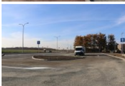
• Obwodnica osiedla Piłsudskiego w Czeladzi
