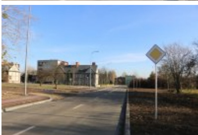
• Obwodnica osiedla Piłsudskiego w Czeladzi
