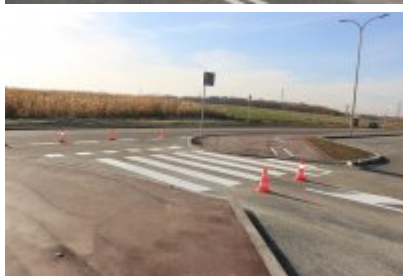
• Obwodnica osiedla Piłsudskiego w Czeladzi
