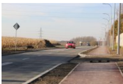
Obwodnica osiedla Piłsudskiego w Czeladzi
